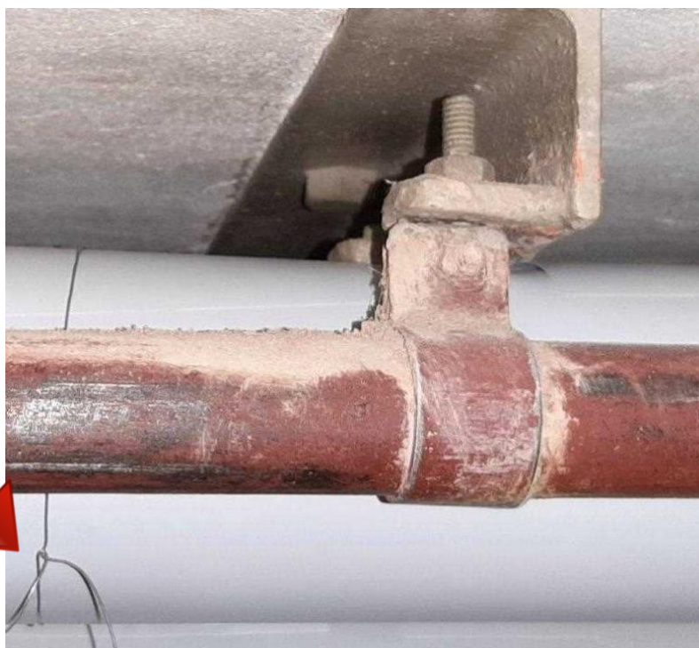
Billedet viser rør i Skydetavle med rester af kiselgur.
